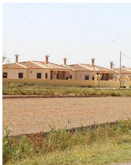
Casas construidas ilegalmente en Catral, que alcanzaron el millar LOINO
